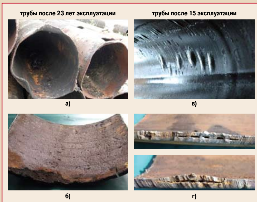
Рис. 1. Внешний вид (а, в) и характерные коррозионные повреждения (б, г) труб после 23 лет (а, б) и 15 лет эксплуатации (в, г)
