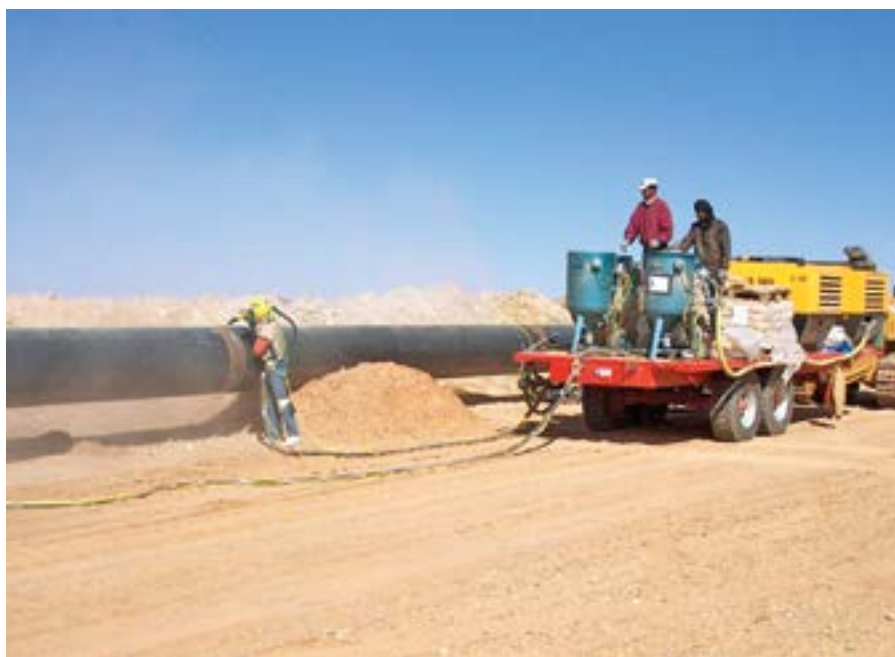
Рис. 1. (а) Оборудование/аппарат, необходимое для выполнения процесса пескоструйной очистки, и (б) фактическая рабочая среда пескоструйной очистки
