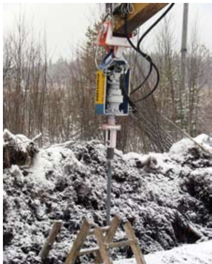
Фото. Завинчивание анкеров в грунт с помощью гидравлического вращателя
