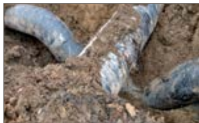
Рис. 1. Наземное обследование крутоизогнутых толстостенных отводов на МГ «Изобильное – Невинномысск» DN 1020
