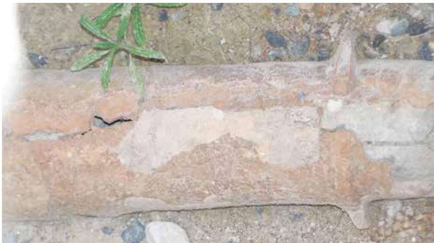
Рис. 1. Фотография сохранившегося до наших дней фрагмента керамического трубопровода, по которому производилось водоснабжение дворца правителя Минойского государства более чем за 2000 лет до н.э.
