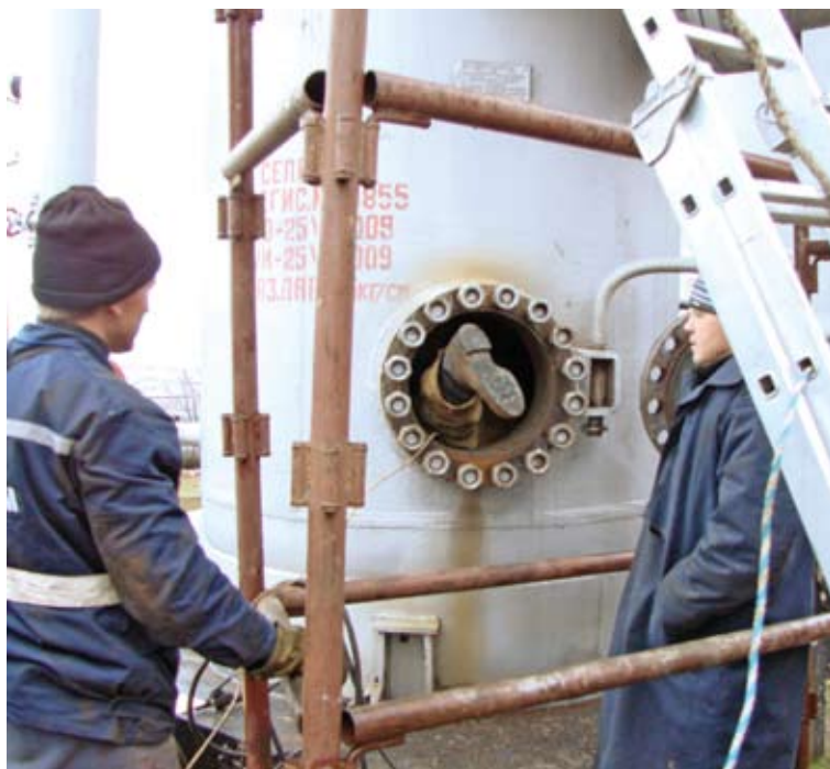
Рис. 1. Пылеуловитель проекта ГП 105 до проведения ремонта по указанной методике
