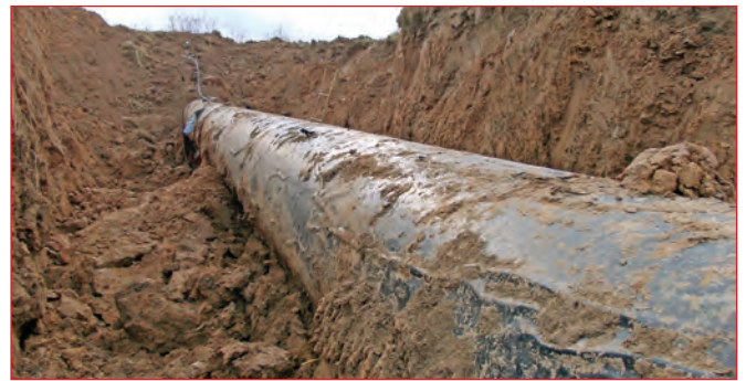
Рис. 1. Общий вид изоляционного покрытия и состояние металла на участках подпленочной коррозии (объекты – магистральные газопроводы, газопроводы-отводы, трубопроводы ПХГ)
