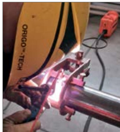
Рис. 10. Сборка трубы DN 80 по технологии МАД на наружном центраторе
