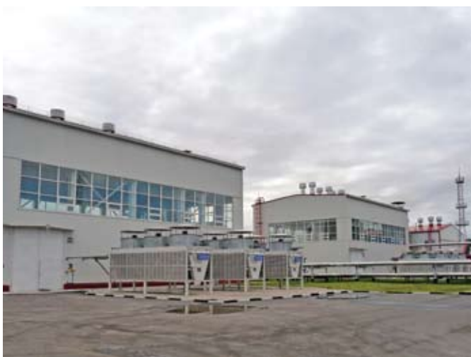
Республика Саха (Якутия). Талаканское месторождение оснащено современной компрессорной станцией
