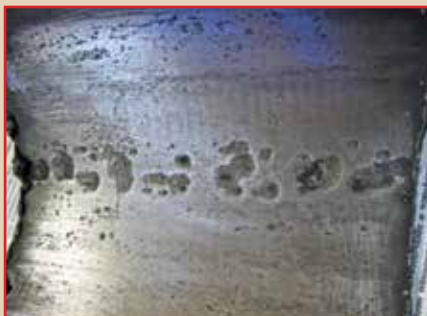
Фото 2. Локализованная внутренняя коррозия по нижней образующей НПТ
