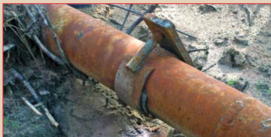
Фото 1. «Хомут» для герметизации аварийного трубопровода на одном из нефтяных месторождений в Удмуртии
