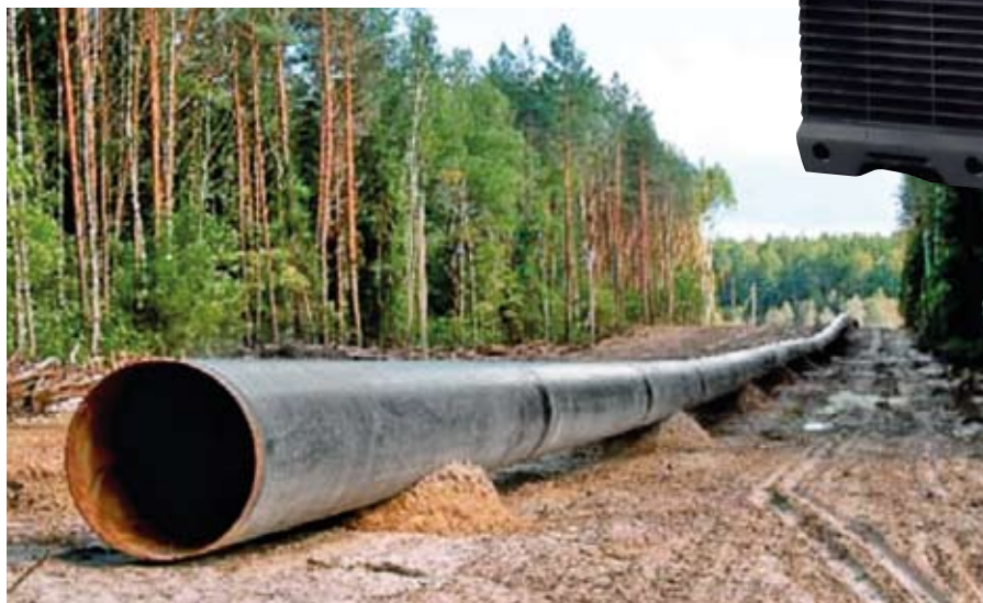
Рис. 1. Дождь, слякоть, лужи, пыль и грязь – обычные условия трассовых и монтажных работ сварщиков
