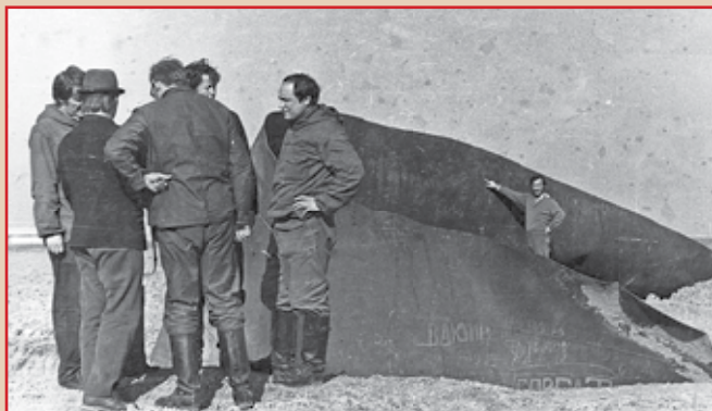
Обследование газопровода Казинь-Магомед–Казань после аварии (разрыв трубы)
