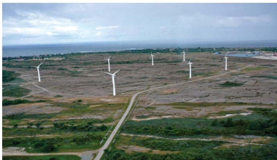
Рис. 4. ВЭС, расположенная на острове Эланд в Швеции рядами перпендикулярно преобладающему направлению ветра
