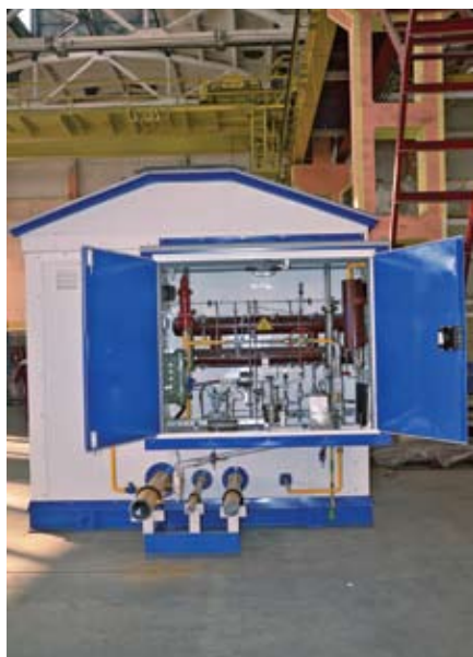
Рис. 3. Одоризатор газа с узлом коммерческого учета газа
