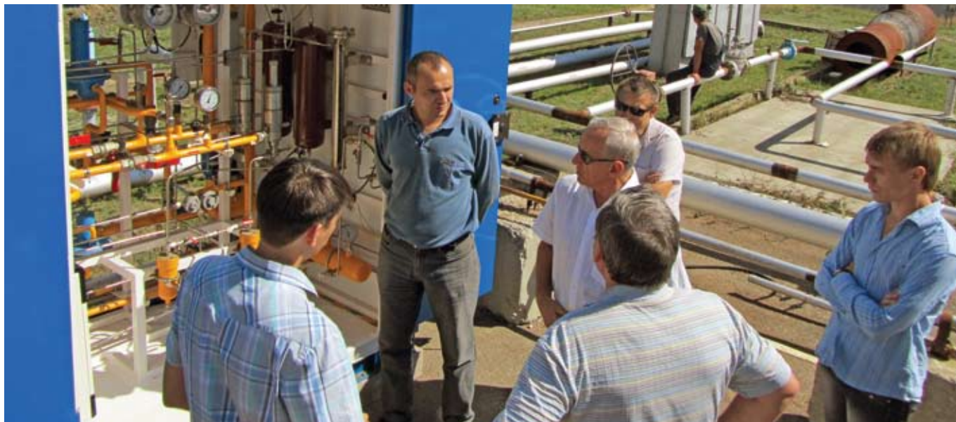
Рис. 1. Приемочные испытания блока подготовки газа
