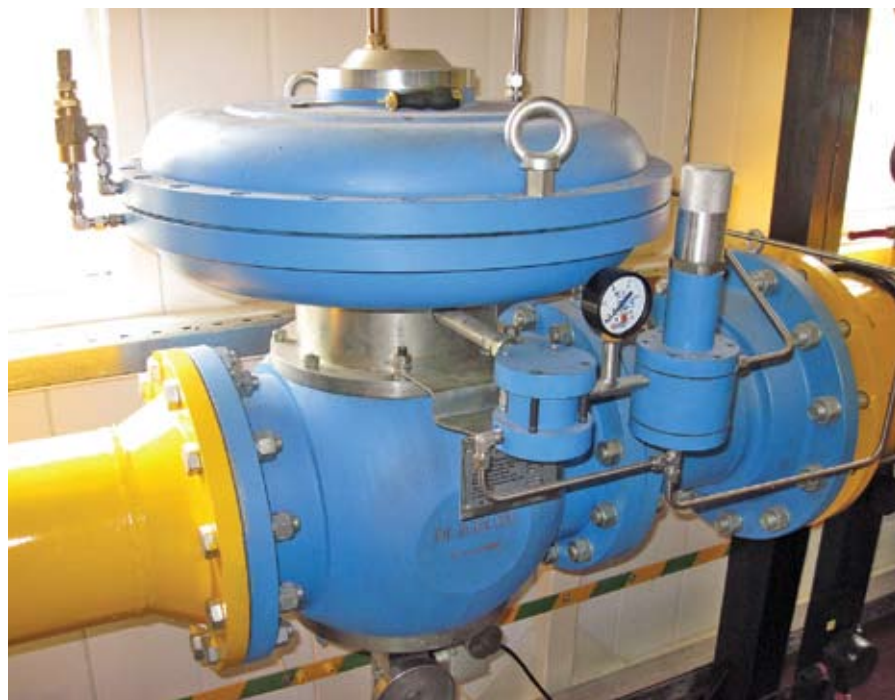
Рис. 4. Регулятор давления газа РД-16-200
