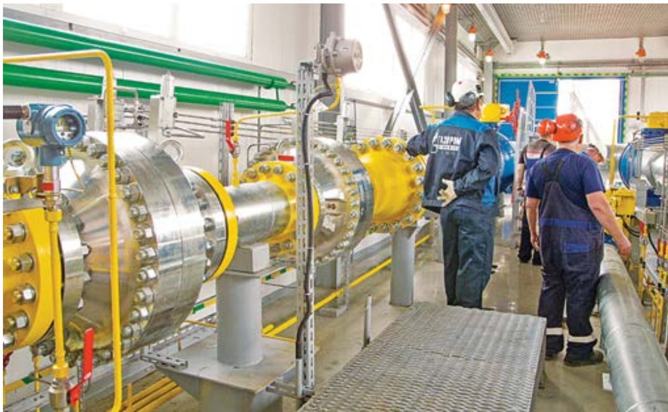
Рис. 1. Регуляторы давления FL/250 DN250 ANSI600 RF в составе ГРС «Нижневартовской ГРЭС» (г. Нижневартовск, ООО «Газпром трансгаз Томск», Александровское ЛПУ МГ)
