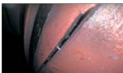
Рис. 4. Разрушение колец жаровой трубы (обнаружено на одной из трех КС)
