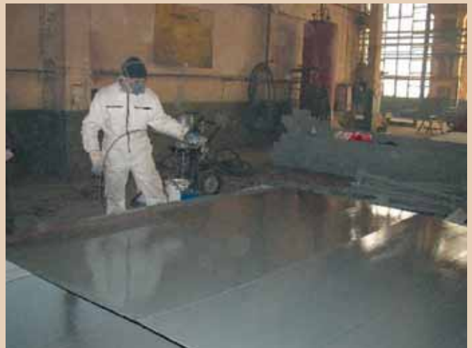
Нанесение слоя грунтовки STELPANT-PU-Zink на элемент кровли для РВС–10 000 м 3 , г. Новокузнецк, 2005 г.
