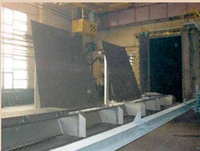
Дробеструйная очистка элементов кровли резервуара 10 000 м 3 на Новокузнецком ЗРМК, г. Новокузнецк, 2005 г.
