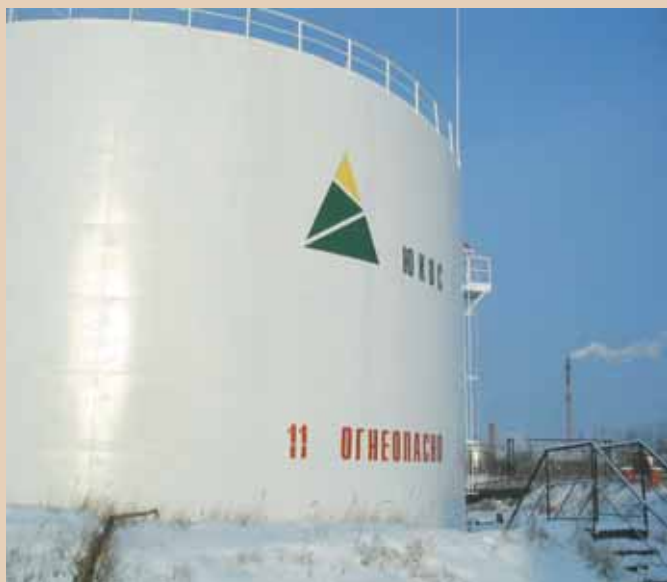
Внешний вид наружного покрытия РВС–5000 м 3 , НК «ЮКОС, г. Нефтеюганск, 2000 г.
