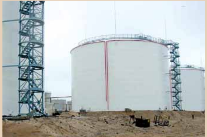
Антикоррозионная защита РВС 10 000 м 3 материалами Stelpant в весенне-летний период 2005 г. в Заполярье (апрель–июнь)
