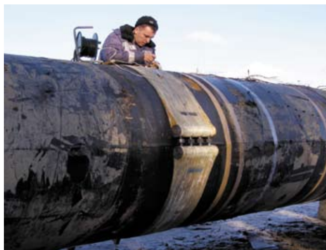
Рисунок 5. Испытания трубы диаметром 1420 мм с муфтами РСМ-1420
