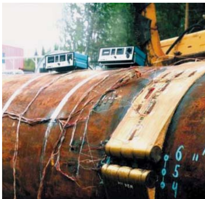
Рисунок 3. Оснащение трубы и муфты РСМ-1220 средствами измерений — тензодатчиками
