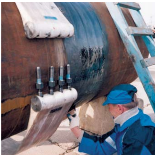
Рисунок 2. Стеклопластиковая муфта РСМ-1220 в момент установки на трубу диаметром 1220 мм
