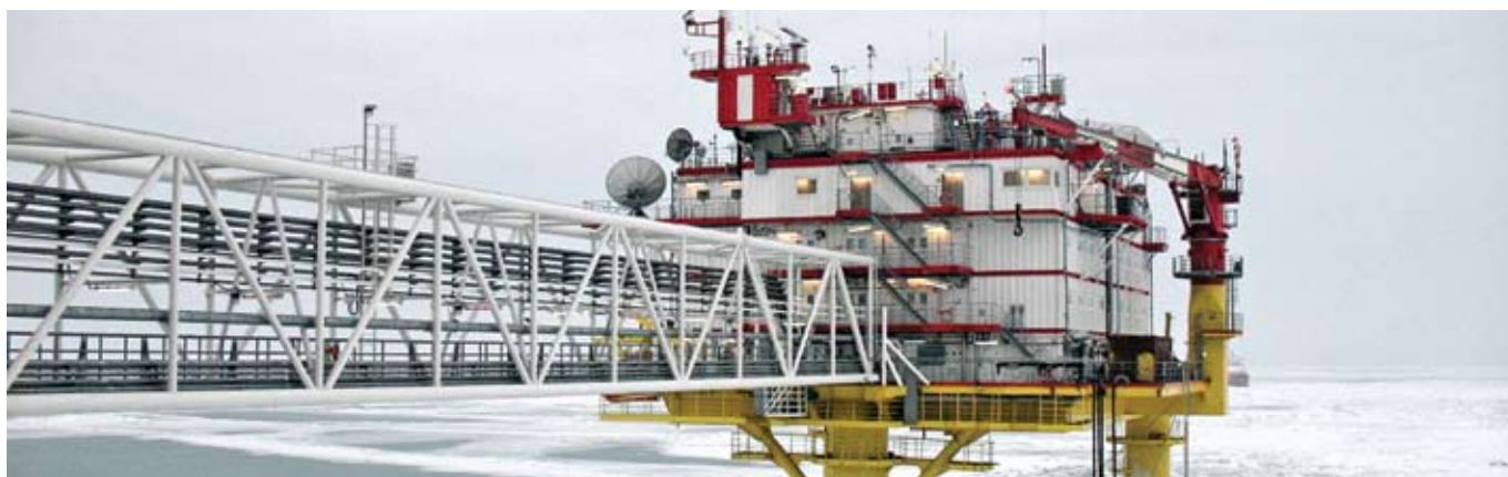
Фото. ЛСП-1 для нефтегазоконденсатного месторождения им. Ю. Корчагина
