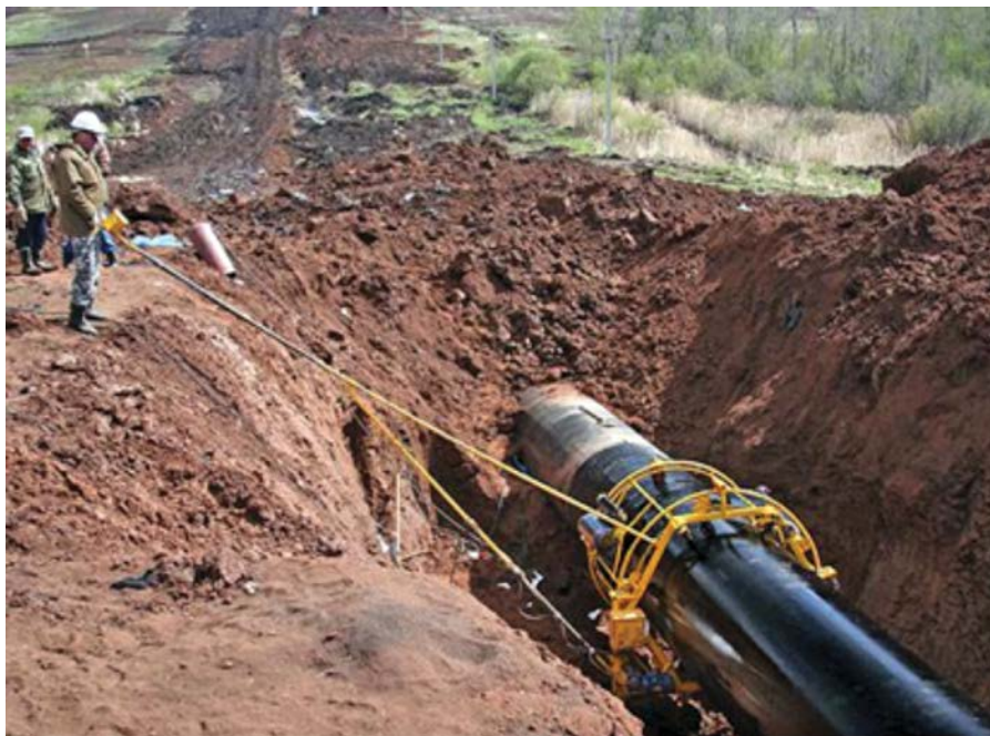
Рис. 3. Машина для механизированной очистки и изоляции локальных участков
