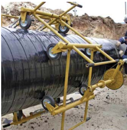
Рис. 2. Ручное приспособление типа «беличьего колеса»
