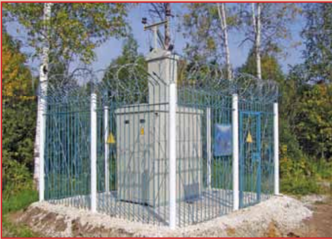
Установка катодной защиты после проведенных ремонтных работ
