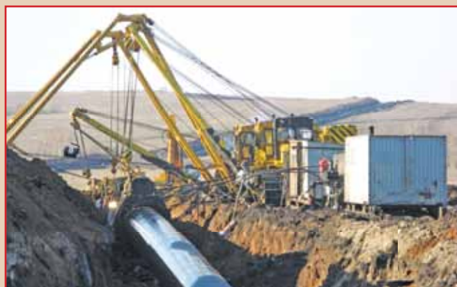
Переизоляция участка магистрального газопровода
