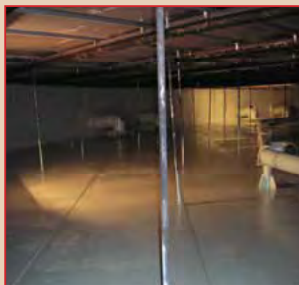
Рис. 5. Общий вид внутренней поверхности резервуара, покрытой системой Matcote®
