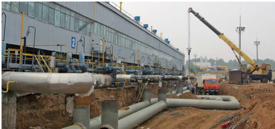
Фото 1. Капитальный ремонт технологических трубопроводов
