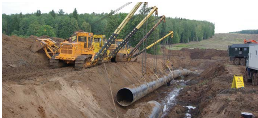
Фото 3. Ремонтные работы на трассе
