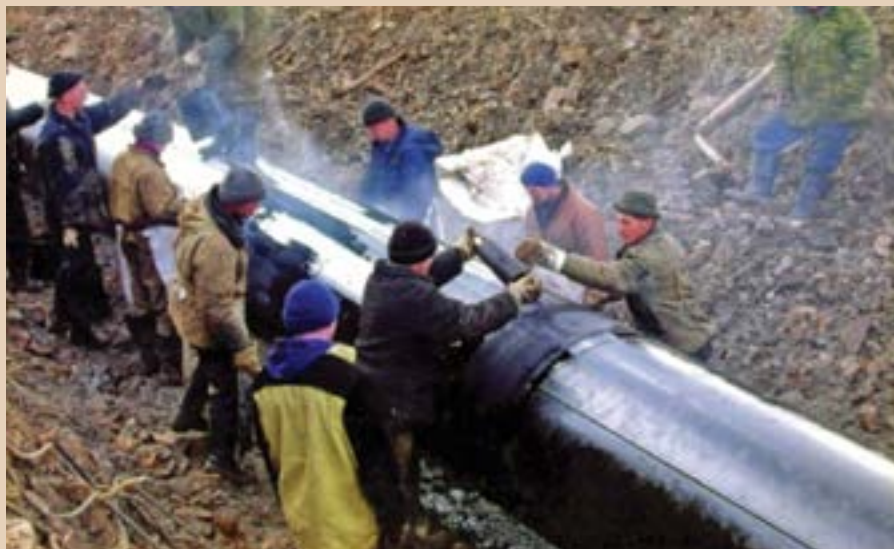
Фото 1. Ручное нанесение покрытия на основе мастики «ТРАНСКОР-ГАЗ»
