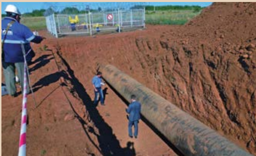
Фото 6. Обследование защитного покрытия в ООО «Газпром добыча Оренбург» после года эксплуатации
