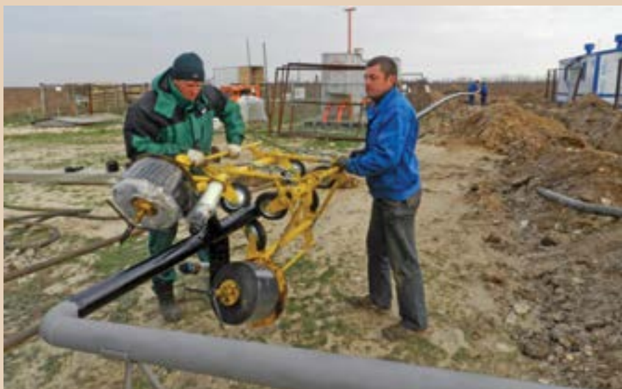
Фото 3. Нанесение защитной конструкции ручным комплексом малой механизации
