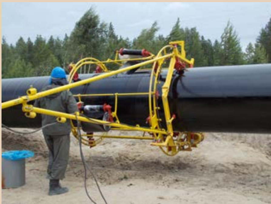
Фото 4. Нанесение защитной конструкции комплексом малой механизации с электрическим приводом
