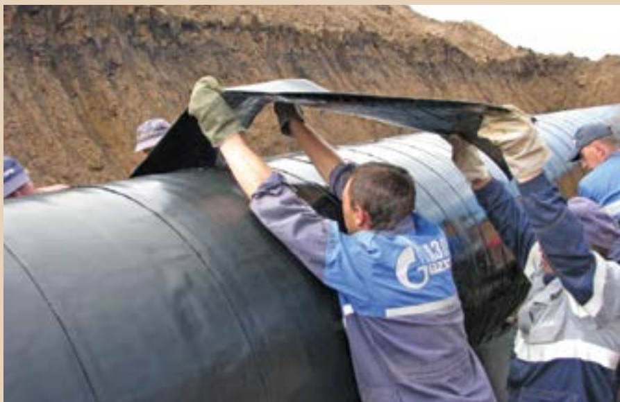
Фото 2. Ручное нанесение покрытия на основе рулонного материала «РАМ»
