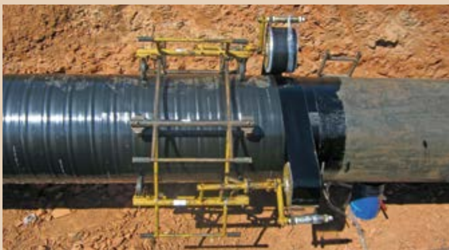
Фото 5. Нанесение защитной изоляционной конструкции «ДЕКОМ-РАМ» ручным изоляционным приспособлением в ООО «Газпром добыча Оренбург»
