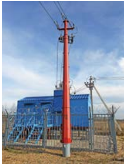
Опоры в составе линии газопровода «Ухта – Торжок»
