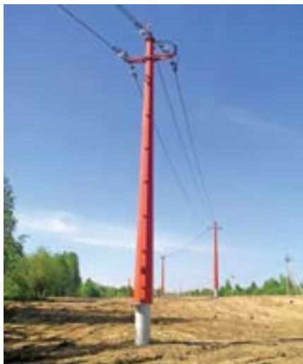
Опоры в составе линии газопровода «Ухта – Торжок»
