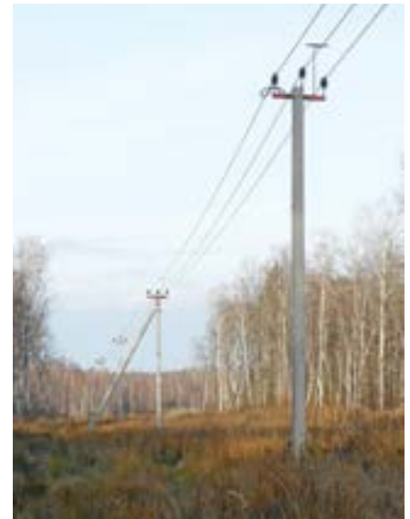
Опоры в составе линии Северо-Европейского газопровода
