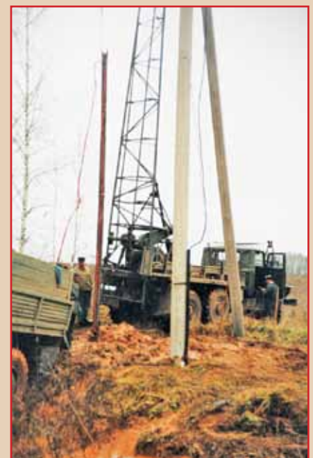
Монтаж первого анодного заземления МГ в 2000 г. (Чайковское ЛПУМГ)
