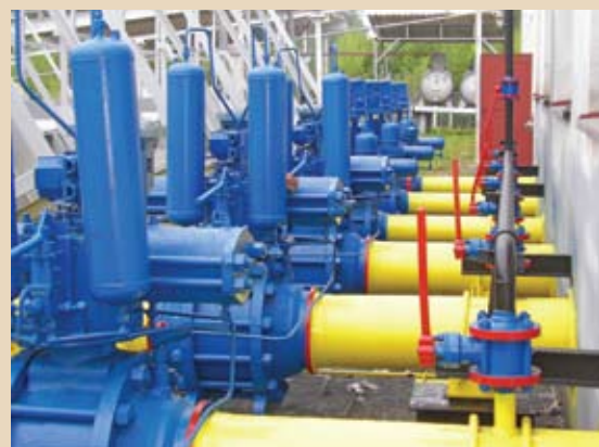
Оханская КС ООО «Газпром трансгаз Чайковский» Покрытие ЦИНОТАН+ ПОЛИТОН-УР +ПОЛИТОНУР (УФ)
