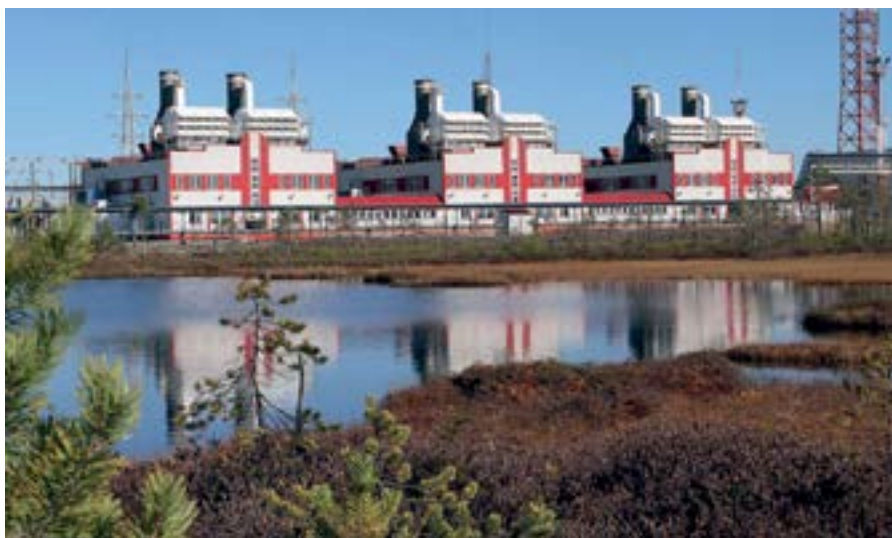
Фото 3. ГТЭС Ватьёганского месторождения работает на попутном газе
