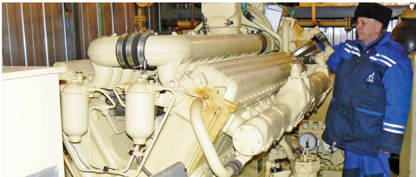
Фото 1. Контроль параметров работы АДЭС
