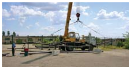
Рис. 5. Испытания плети с соединением RJ на внутреннее давление с изгибом
