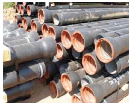
Рис. 8. Партия труб из ВЧШГ под соединения типа RJ, подготовленная к монтажу трубопровода
