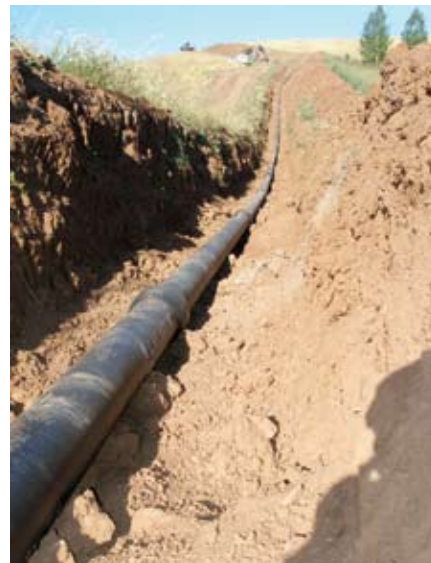
Рис. 9. Трубопровод Ду 200 мм, смонтированный из труб ВЧШГ с применением соединений типа RJ
