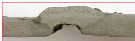
Рис. 1. Коррозионное разрушение кольцевого стыка трубопровода
