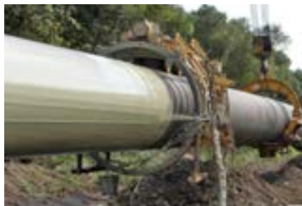
Рис. 3. Оборудование для нанесения покрытия
