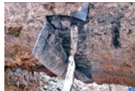
Рис. 2. Мастично-битумное покрытие («Транскор-Газ»)
