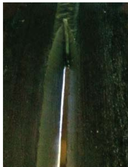
Рис. 4. Выборка сварного шва
