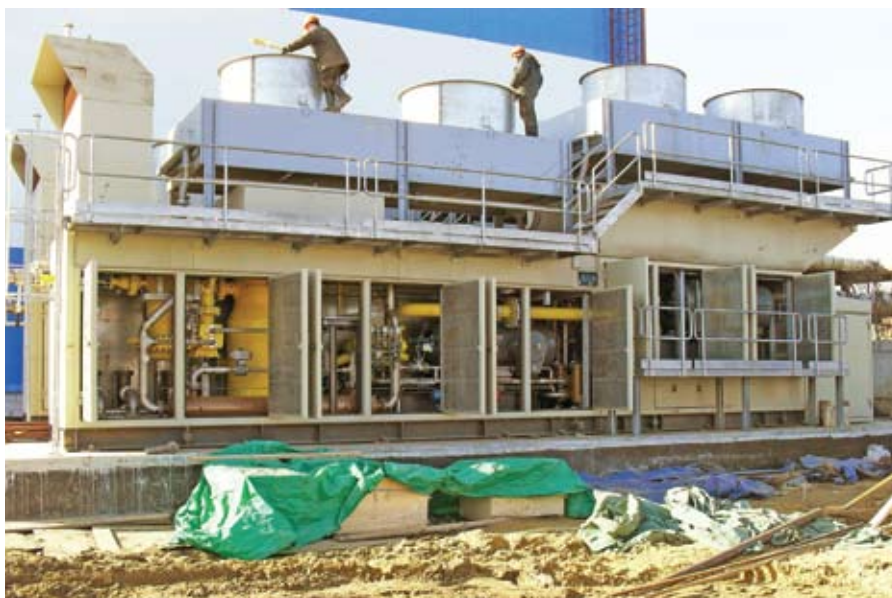
Фото 3. Шефмонтаж ДКУ ENERPROJECT серии EGSI-S-300/1000-100/1000 WA
