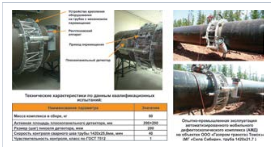
Рис. 5. Цифровой радиографический контроль качества сварных соединений.
