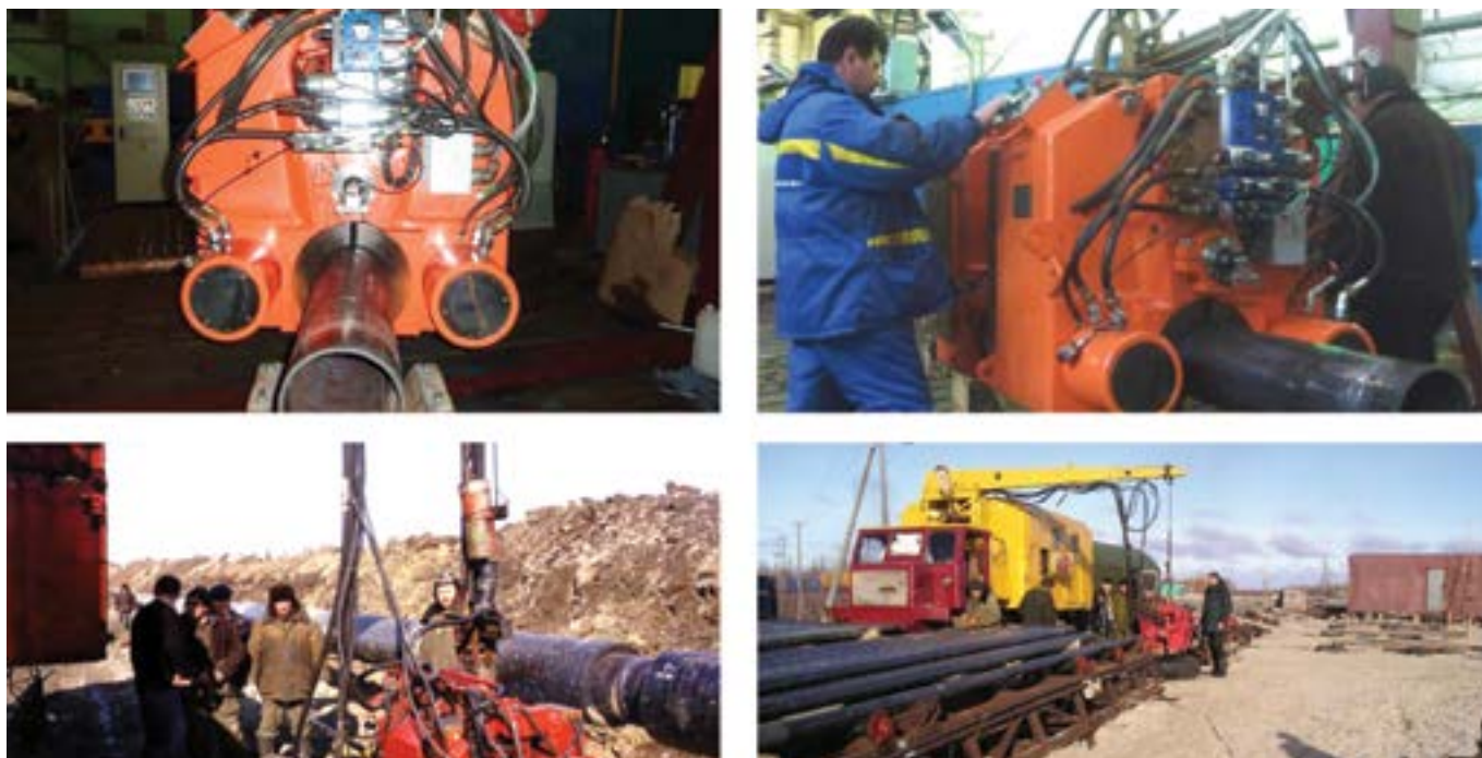
Рис. 11. Автоматическая контактная стыковая сварка оплавлением (КСО) труб малых диаметров с применением машин К584М (от DN 50 до DN 300 с толщиной стенки 2,5–16,0 мм)
