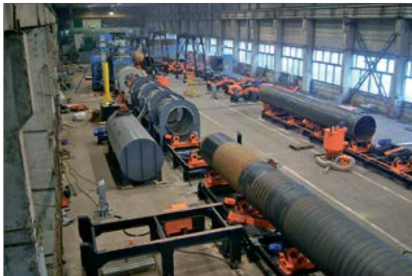
Рис. 1. Мобильная технологическая линия по ремонту и изоляции труб повторного применения ЗАО «Стройтранснефтегаз»
