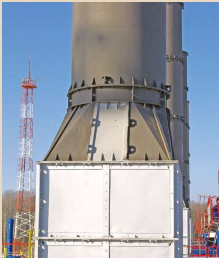
Фото 1. Контрольный участок, окрашенный материалом Армокот ТЕРМО
