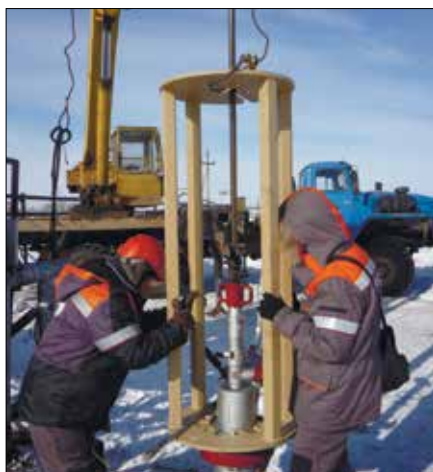
Фото 1. Установка подставки на планшайбу
