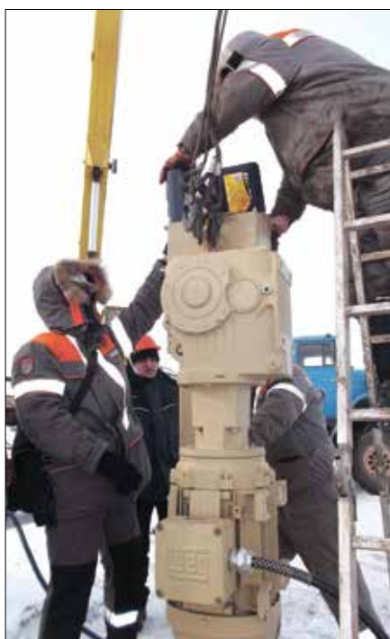
Фото 2. Заливка масла в редуктор
