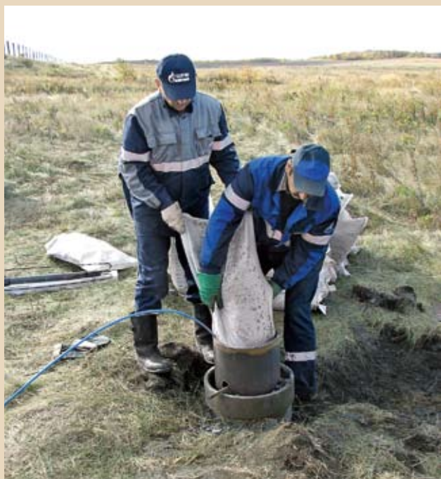
Рис. 5 – Засыпка в скважину коксо-минерального активатора КМА
