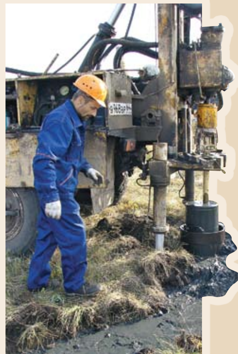
Рис. 2 – Промывка обсадной колонны ГАЗ
