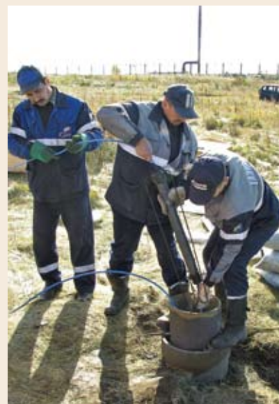
Рис. 4 – Монтаж магнетитового заземлителя «Менделеевец»-МТ
