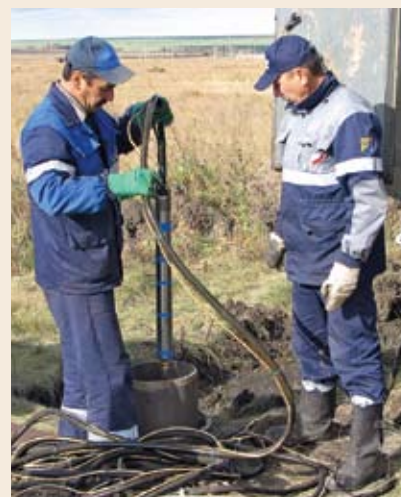
Рис. 3 – Откачка воды из обсадной колонны
