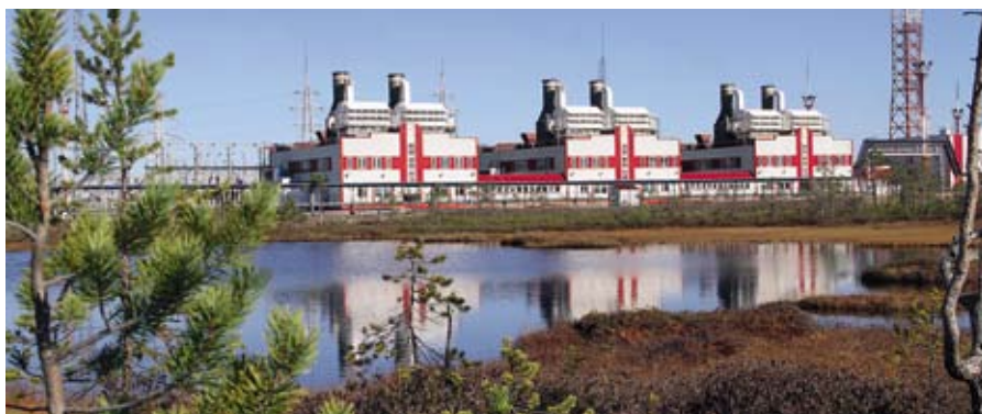
Рис. 2. Газотурбинная электростанция ГТЭС-72 на Ватьеганском МНГ, ООО «ЛУКОЙЛ – Западная Сибирь»
