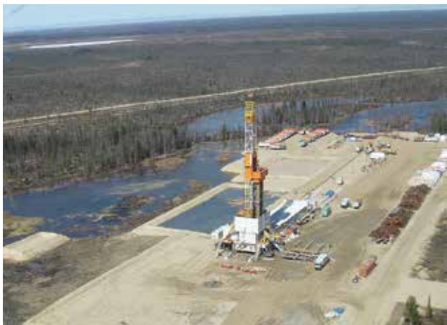
Новая современная БУ «Уралмаш» 4200/250 ЭКБМ зав. № 14771, находится в эксплуатации на Олимпийском лицензионном участке к.№ 11 – осуществляет работу на Заказчика ОАО «НОВАТЭК»
