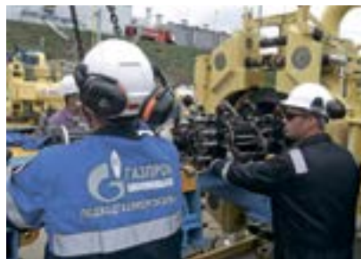
Рис. 2. Диагностическое обследование участка магистрального газопровода с применением внутритрубного прибора дефектоскопа
