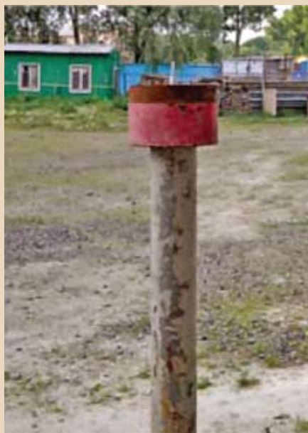
Рис. 1. Контрольно-измерительные пункты различной конструкции, выполненные из стальной трубы с клеммной панелью в системах ПКЗ МГ по ГОСТ 25812-83
