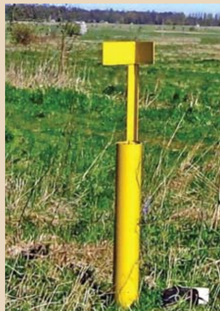
Рис. 1. Контрольно-измерительные пункты различной конструкции, выполненные из стальной трубы с клеммной панелью в системах ПКЗ МГ по ГОСТ 25812-83
