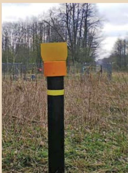
Рис. 2. КИП различных типов из полиэтиленовой трубы, оборудованные плакатом с идентификационной надписью в системе ПКЗ МГ Ямал – Европа
