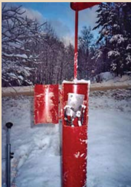
Рис. 1. Контрольно-измерительные пункты различной конструкции, выполненные из стальной трубы с клеммной панелью в системах ПКЗ МГ по ГОСТ 25812-83
