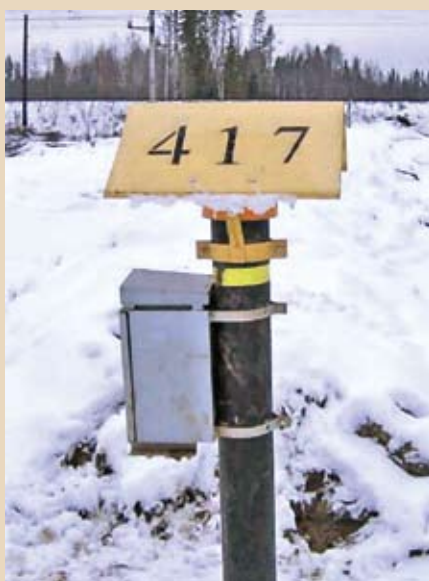
Рис. 2. КИП различных типов из полиэтиленовой трубы, оборудованные плакатом с идентификационной надписью в системе ПКЗ МГ Ямал – Европа
