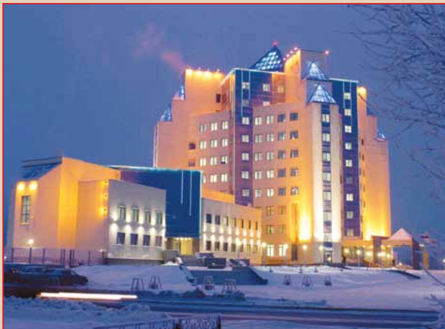
Здание АУП ООО «Газпром трансгаз Югорск»
