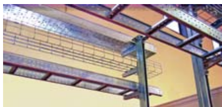
Рис. 1. Внешний вид легких кабельных модульных эстакад
