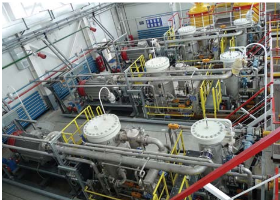
Фото 2. Система газоподготовки «ЭНЕРГАЗ-Enerproject» ангарного типа на ГТЭС Талаканского месторождения (ОАО «Сургутнефтегаз»)
