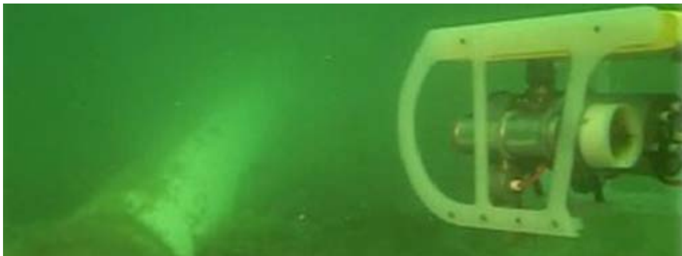
Рис. 2. Уточнение параметров дефектов с помощью подводного дистанционно управляемого аппарата
