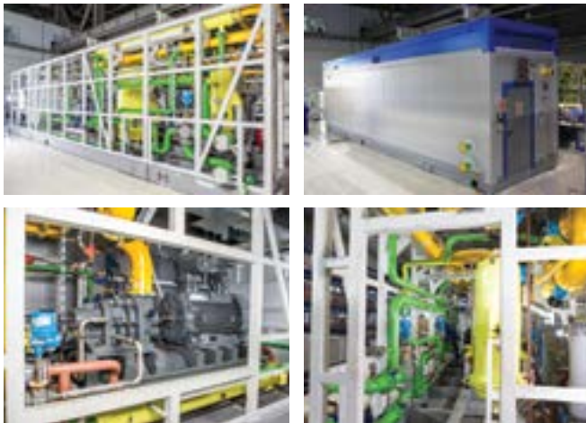
Рис. 4. Компрессорный модуль МКУ
