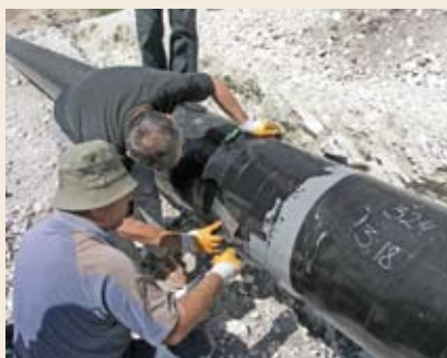
Фото 8. Нанесение на сварной стык наружного защитного покрытия (2-й слой).
