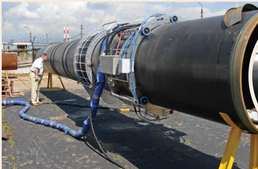
Фото 1. Комплектное оборудование фирмы «PIN» для предварительного индукционного нагрева и нанесения на сварные стыки труб двухкомпонентного полиуретанового покрытия
