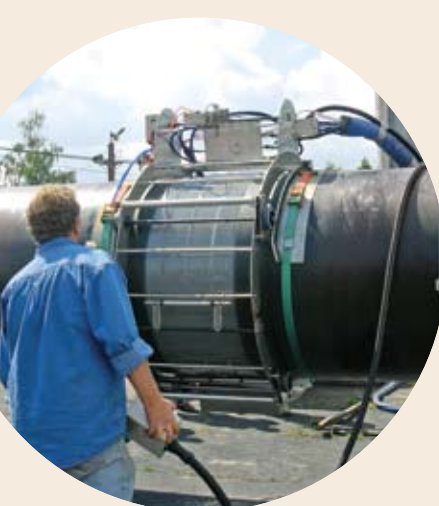
Фото 2. Нанесение в условиях ИЭПЦ ВНИИСТА (п. Толбино Московской обл.) на сварные стыки труб \varnothing 1220 мм двухкомпонентного полиуретанового покрытия «Scotchkote 352»
