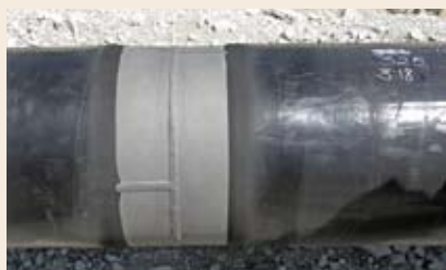
Фото 5. Участок сварного стыка трубопровода \varnothing 530 мм после абразивной очистки.
