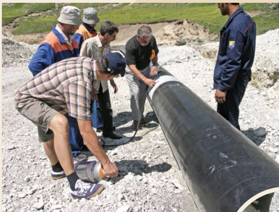
Фото 6. Обработка зоны сварного стыка трубопровода газом-активатором.
