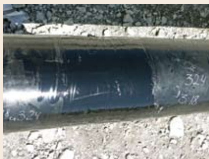
Фото 9. Зона сварного стыка с двухслойным защитным покрытием «МАНАС-СТ».
