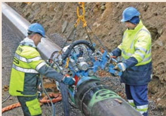
Фото 10. Монтаж на участок сварного стыка газопровода установки «WehoCoat» фирмы «KWH»
