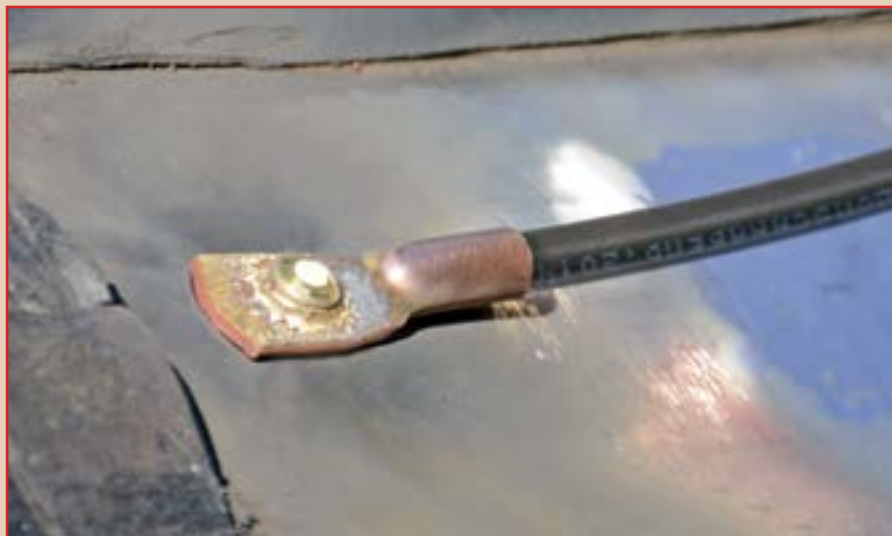
Рис. 2. Результат припайки катодного вывода
